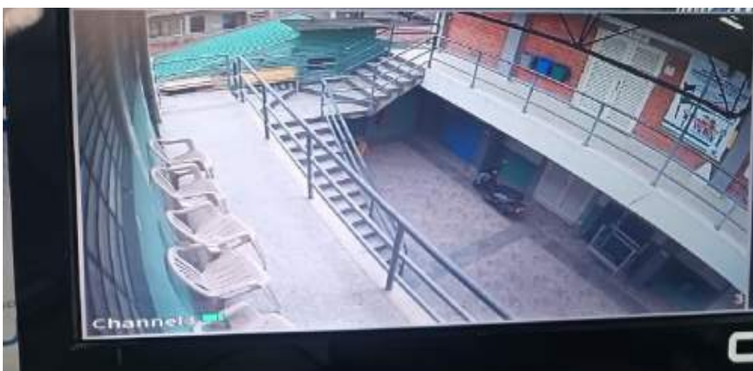
Pasillo y escaleras de acceso Secretaría Académica Sede Central
