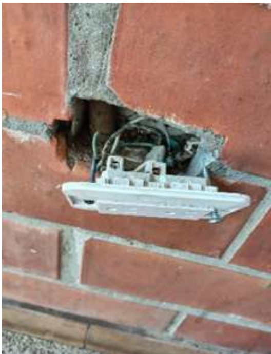
4.3.3.5 Arreglo tomacorriente corredor pasillo coordinación Lizandro Franky
